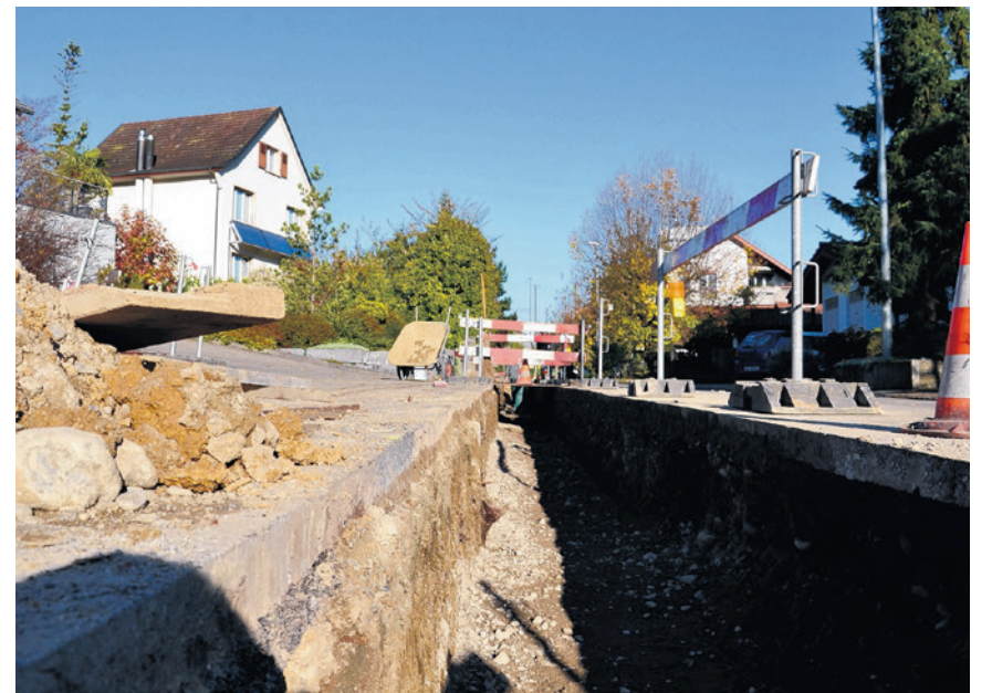
In Böckten wird eine neue Trinkwasserleitung gelegt.
